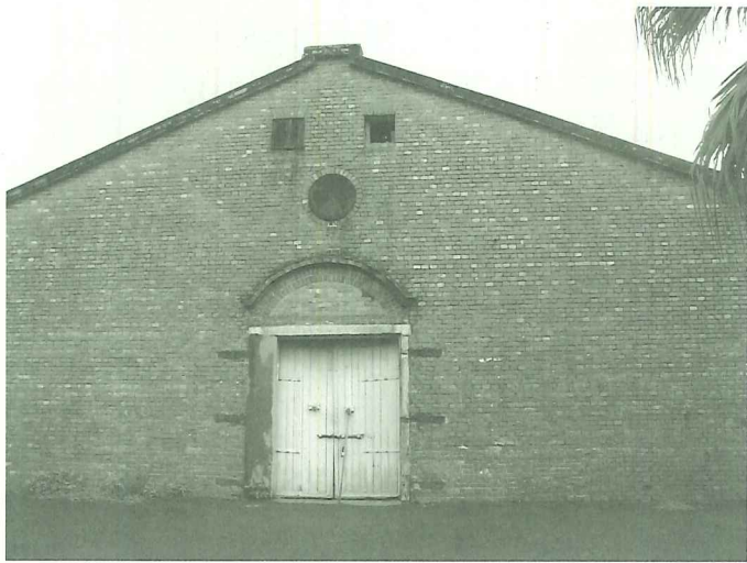
殼牌倉庫九月份後將動工整修 (攝影/梁建新)
